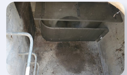
Después de la instalación de un FCD
